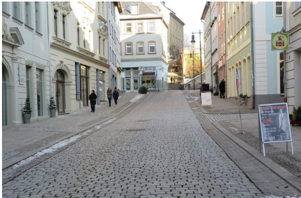
Abbildung 21: unebenes Kleinpflaster auf der Großen Kirchstraße
