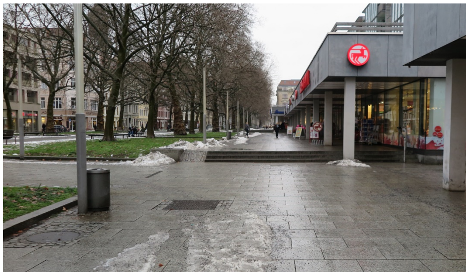
Abbildung 34: seitlicher Gehbereich in der Fußgängerzone Hauptstraße sowie links im Hintergrund der mittlere Gehstreifen mit Kleinpflaster-Belag
